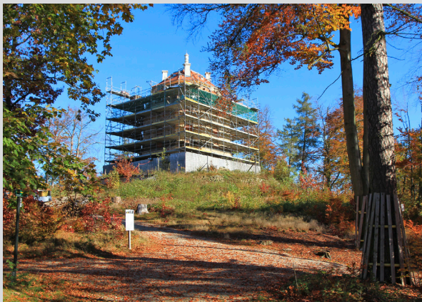
Seit 2019 wird das Hellhaus saniert (Foto Oktober 2021).
